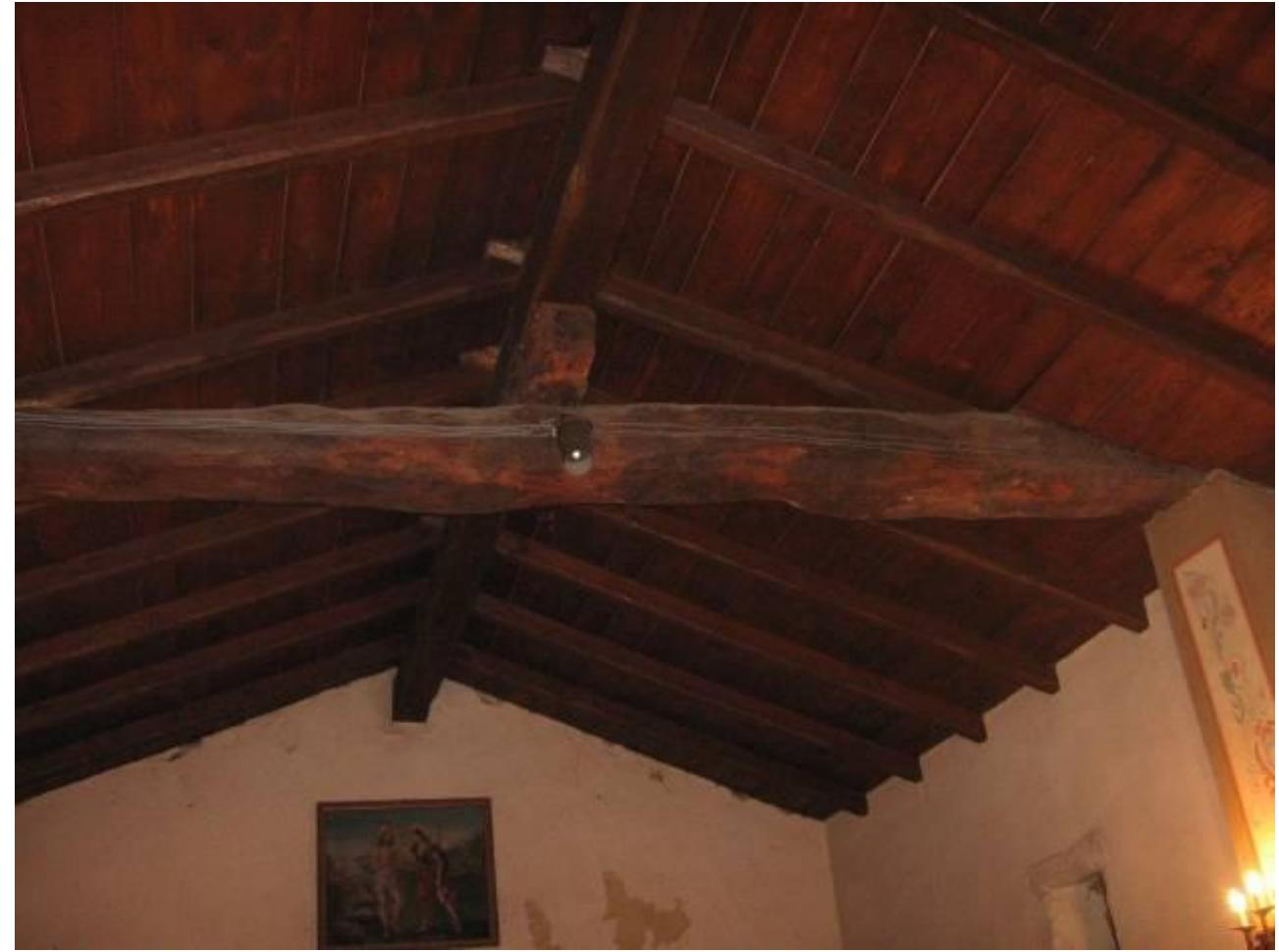
*Figura 7 - Particolare copertura navata*
