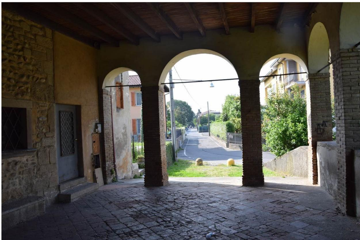
I pilastri di sostegno sono a sezione quadrata di cm. 49x49, in mattoncini in laterizio a vista, collegati fra loro, in corrispondenza degli archi, da catene in ferro.
