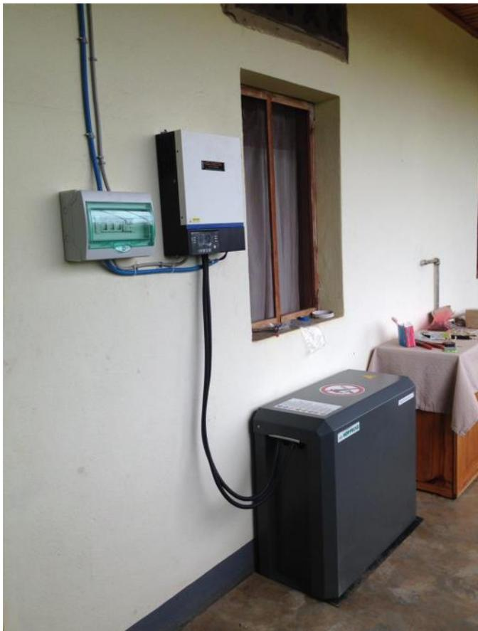
*Inverter, quadro elettrico e batteria che completa l'impianto a isola.*
