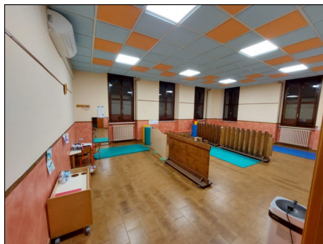
Nuovi controsoffitti alla Scuola dell'Infanzia
